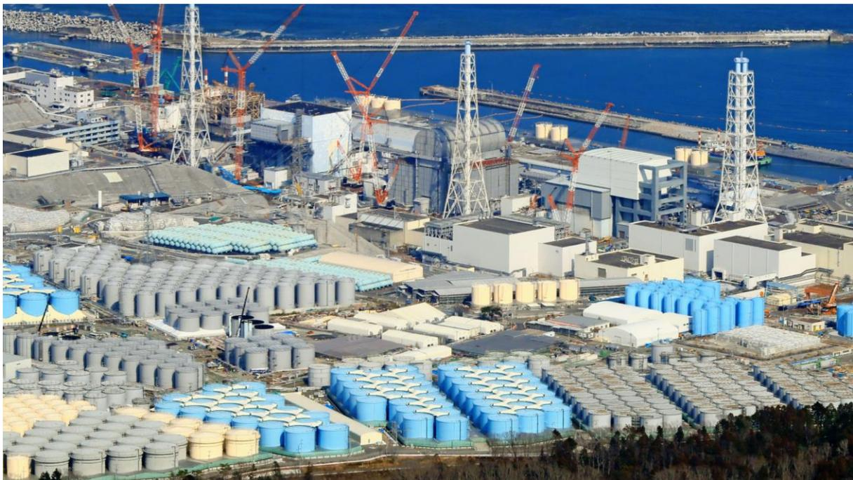
**Abbildung 1:** Kontaminierte Wassertanks in Fukushima.<sup>[6]</sup>
